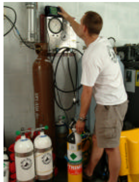
ATA™ im Einsatz an einer mixgas füllanlage
